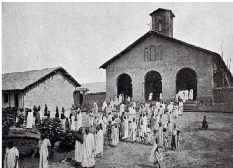
L'EGLISE DE MARIENBERG CONSTRUITE PAR LE FR. ALFRED ET SES OUVRIERS
