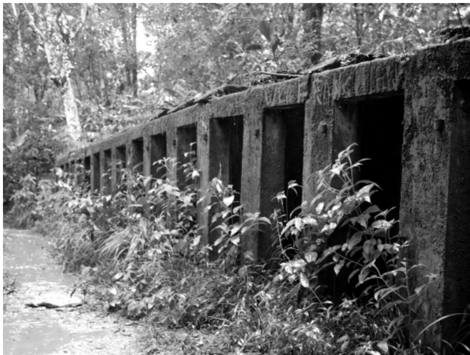
Vestiges du « bagne des Annamites » à Montsinéry-Tonnegrande. Les cellules mesurent 1x2m. Plusieurs centaines d'indépendantistes d'Indochine ont été déportés en Guyane en punition de leur résistance et chargés de l'impossible tâche de construire une voie de chemin de fer en pleine forêt.
